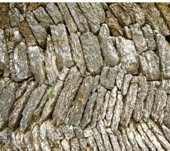
meglio la spinta del terreno. Nelle marogne più elevate si provvedeva anche a curvare il profilo per aumentare la capacità di resistenza e a ricavare con blocchi sporgenti delle scalette di comunicazione fra una quara e l'altra.
